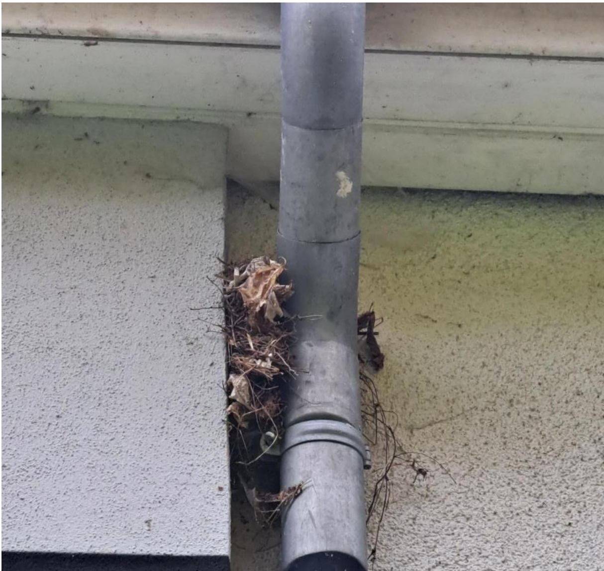
altes Amselnest an der Dachrinnen Hinterfront Gebäude, 14.10.2025
